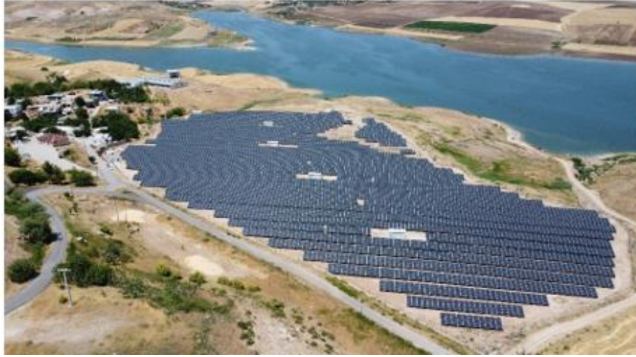
Adıyaman'da bulunan Denk, Yaka, Maya, Kelam GES lerin Havadan Çekilmiş Görüntüsü
